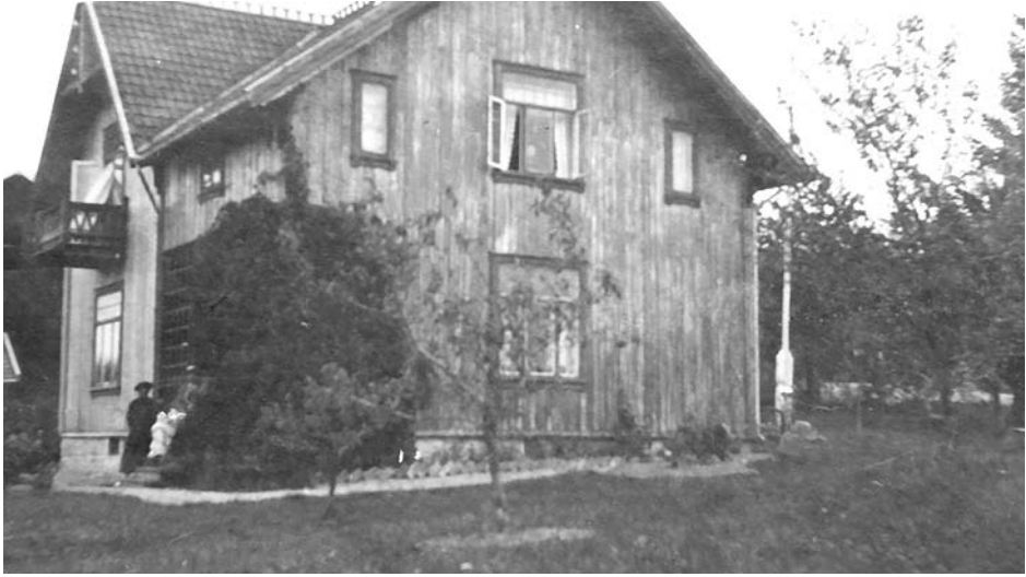
Bygningen fotografert på Nordre Klemetsrud
